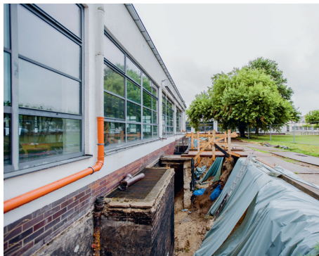
Eine Abböschung des Geländes soll für mehr Licht im Untergeschoss des Gebäudes führen.
