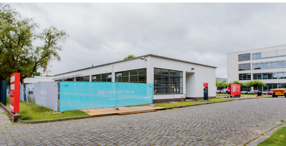
Beginn der Bauarbeiten im ehemaligen Pförtnerhaus im Frühjahr 2016.
